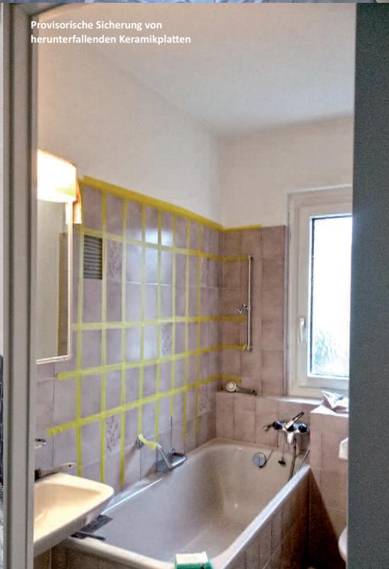
Provisorische Sicherung von herunterfallenden Keramikplatten
