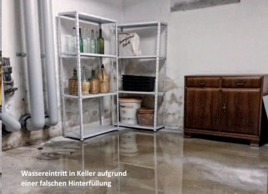
Wassereintritt in Keller aufgrund einer falschen Hinterfüllung
